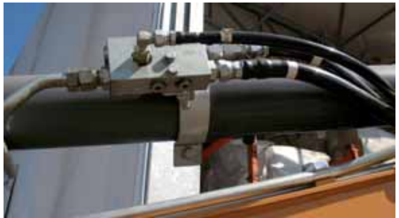
Sicherheitsventile des Hebezeugpakets
